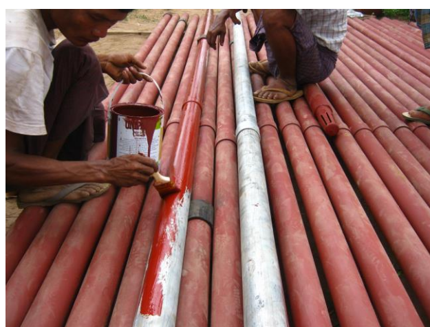
写真 12 揚水管に弁柄塗布作業
