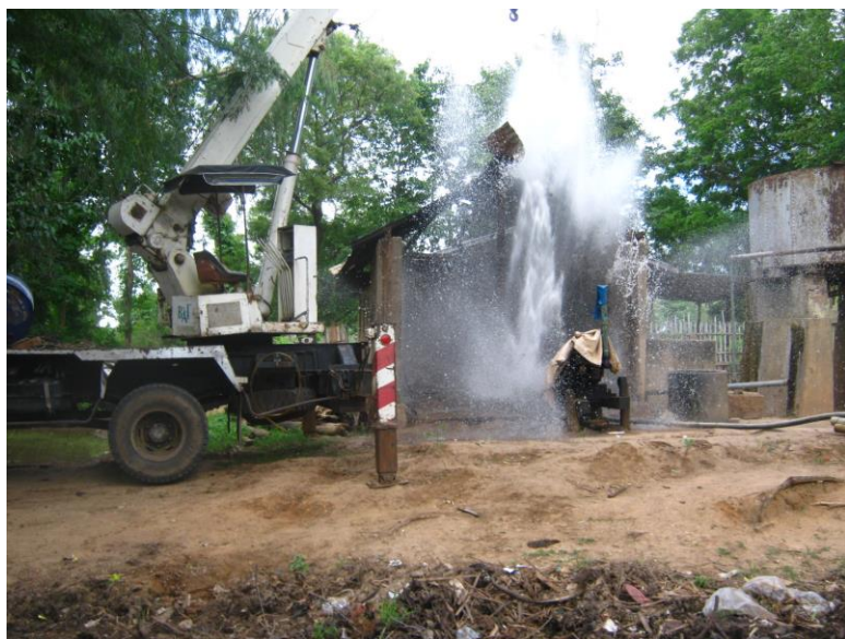
写真 7 既存井戸孔内洗浄（エアリフティング）
