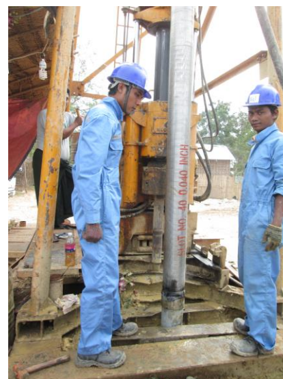
写真2 スクリーンパイプの設置
