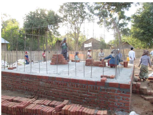
写真3 貯水タンク建設工程
