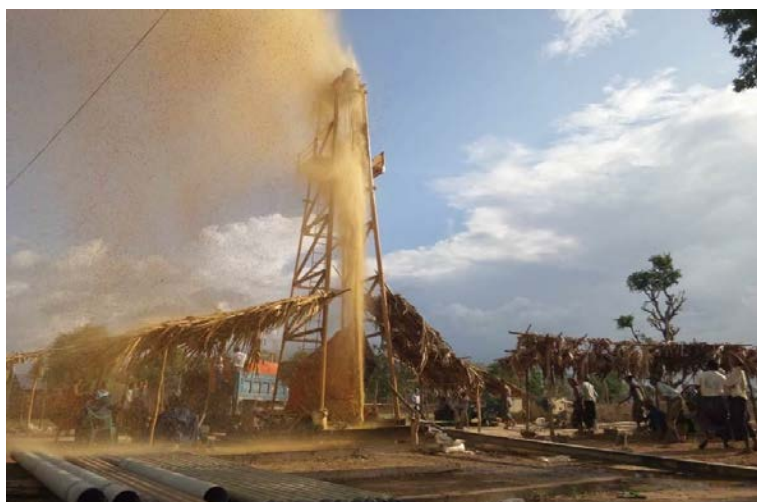
写真1 新規井戸孔内洗浄（ディベロッピング）
