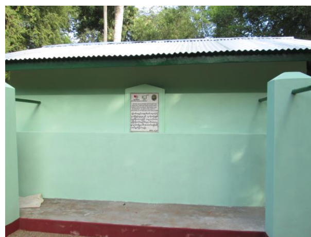
写真4 5000 ガロン貯水タンク完成
