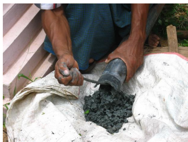
写真 10 揚水管内の泥のかき出し
