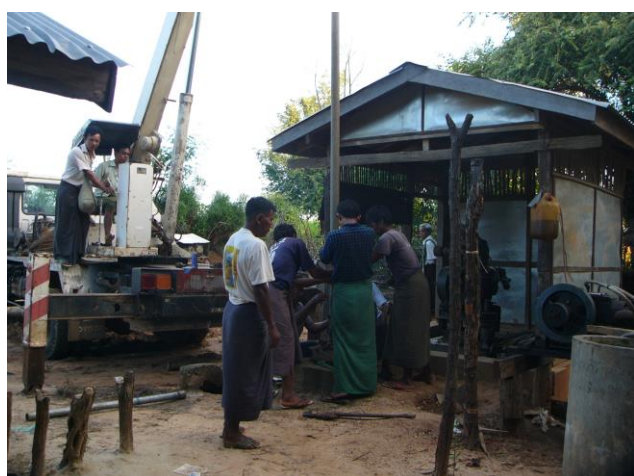
写真 11 ポンプ及び揚水管の取出し作業
